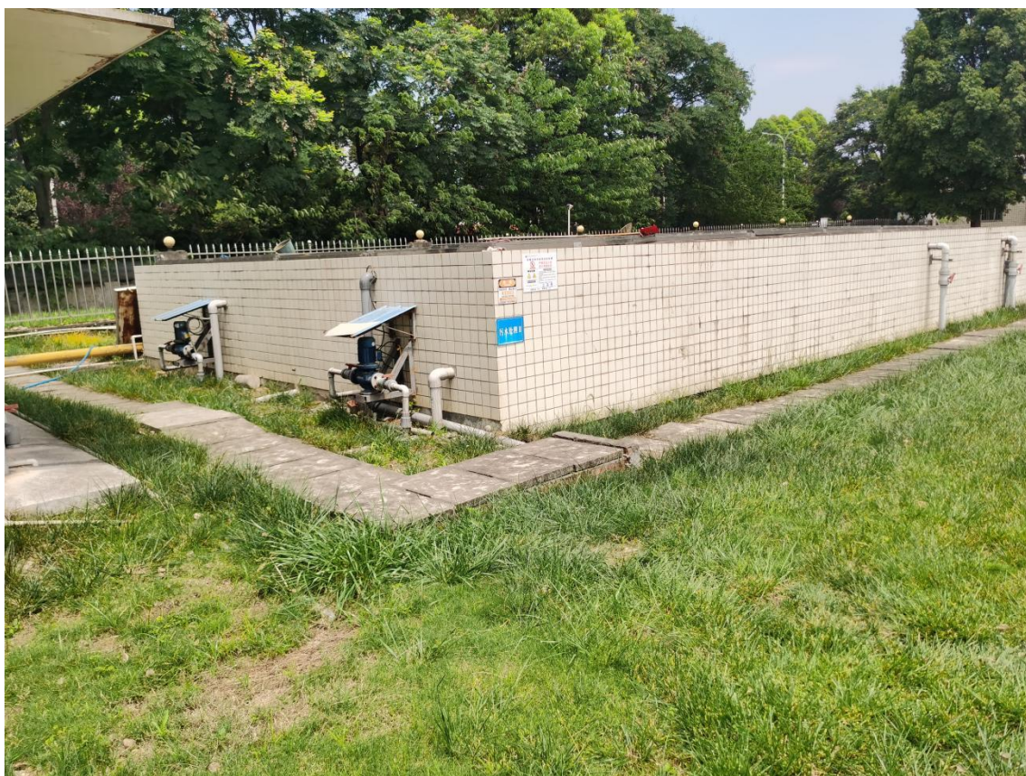
图 4-5 污水处理厂隐患排查
